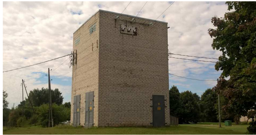
49. attēls "Transformatora apakšstacija Augstkalnē" (foto P. Grants 16.08.17.)
