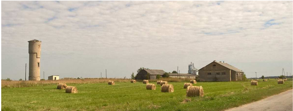
65. attēls "PSRS laikā uzbūvētās būves" (foto P. Grants 16.08.17.)
