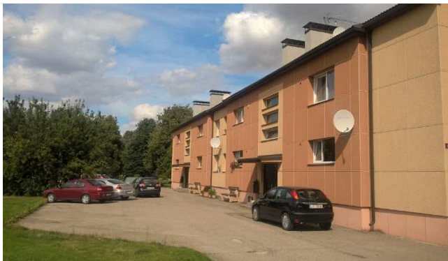
9. attēls "Renovētā daudzdzīvokļu māja "Ziedoņi" Kroņaucē" (foto P. Grants 16.08.17.)
