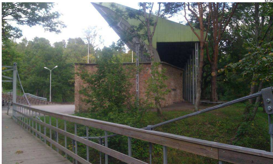
3.11.2. attēls. Dobeles pilsētas Ķestermeža estrādes esošais veloseliņa apgaismojums un teritorija, kurā ieteicams uzstādīt papildus apgaismojumu publiskās telpas drošības apsvērumu dēļ.
