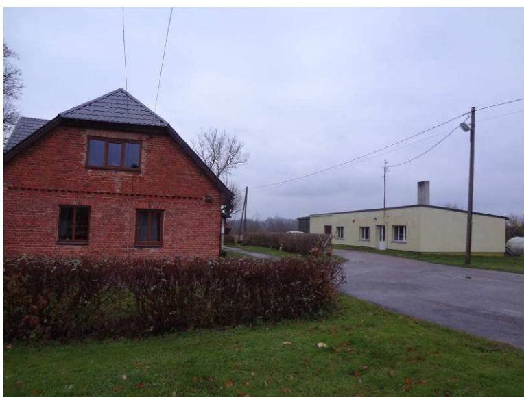
5.4.8. attēls. Penkules pamatskola „Vecā skolas” ēka un darbmācības kabinetu korpuss ar katlu telpu, starp kuriem pazemes siltumtrasē krājas gruntsūdeņi
