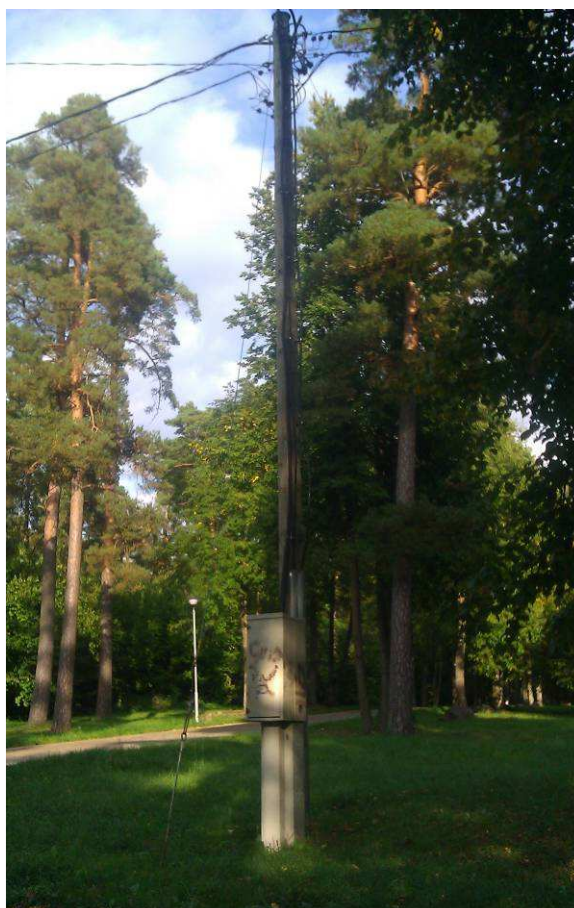
3.11.3. attēls. Dobeles pilsētas Ķestermeža estrādes teritorija, kurā ieteicams uzstādīt papildus apgaismojumu publiskās telpas drošības apsvērumu dēļ.
