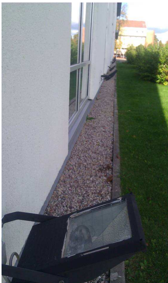
4.2.2. attēls. Dobeles pilsētas sporta halles fasādes apgaismojums
