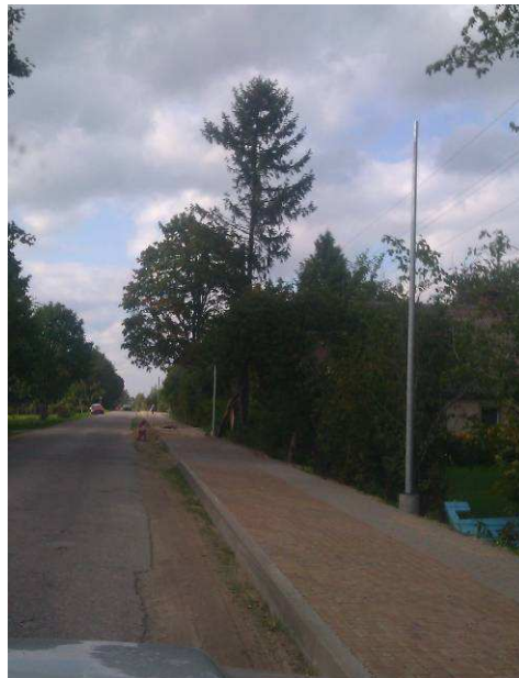
3.15. attēls. Dobeles pilsētas Zaļās ielas veloseliņa apgaismojums būvniecības procesā
