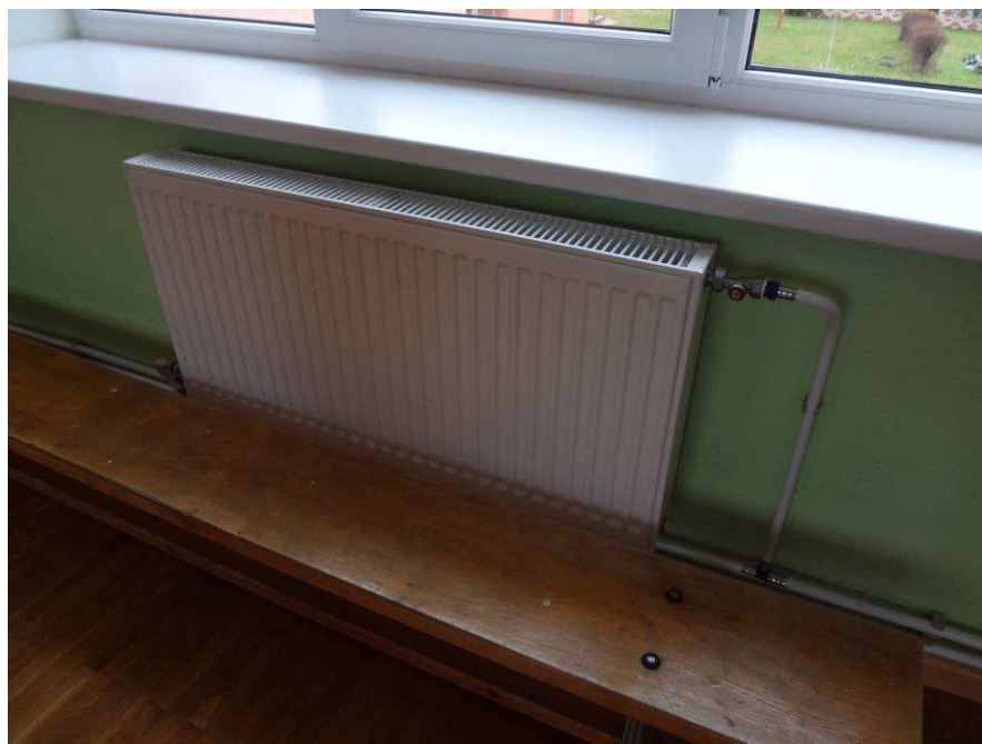
5.5.5. attēls. Kaķenieku PII "Riekstiņš" radiatori ar termoregulatoriem, kas nav piemēroti skolas telpām (regulators noņemts)
