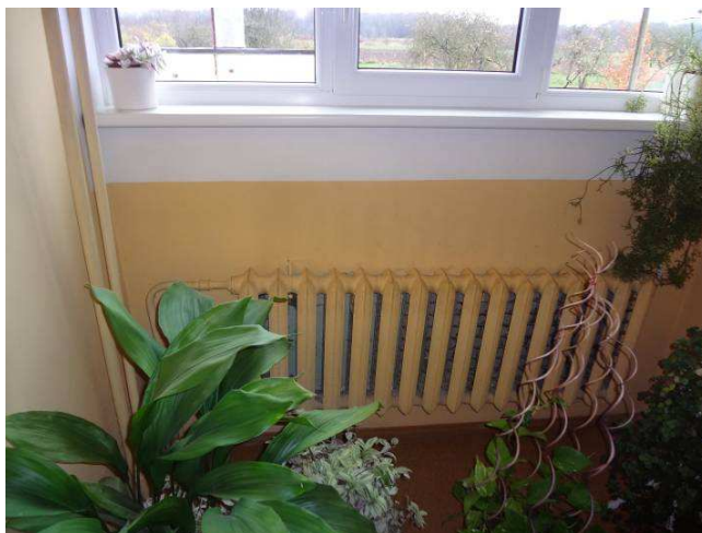
5.4.10. attēls. Penkules vecās skolas ēkas 2. stāva čuguna radiatori (pagasta pārvaldes telpās)
