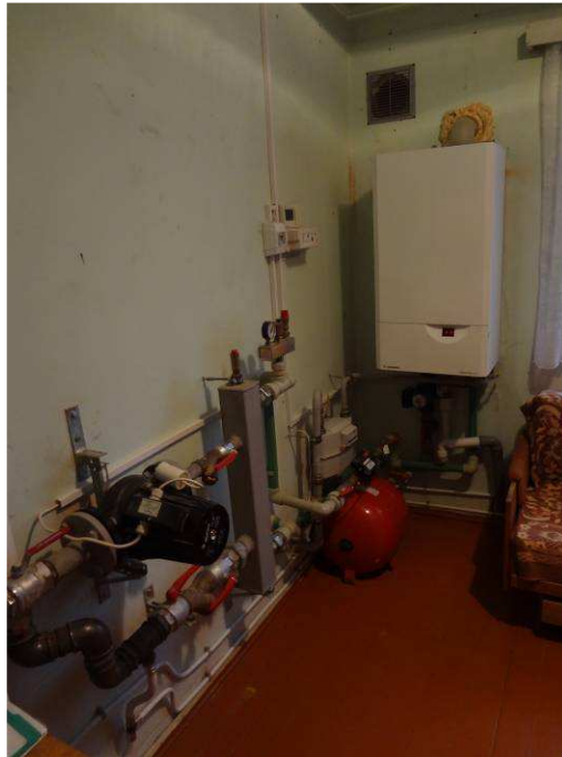
5.1.3. attēls. Anneniekus pamatskolas siltummezgls ar modernu Junkers apkures katlu. Redzams sistēmas izmēriem neatbilstoši jaudīgais ūdens cirkulācijas sūknis
