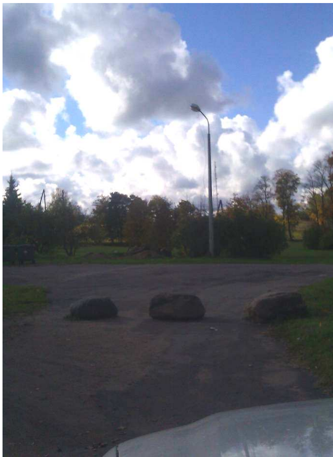
3.7.3. attēls. Lielbērzes ciema esošais nolietotais apgaismojums. Teritorija, kurā ieteicams uzstādīt apgaismojumu publiskās telpas drošības apsvērumu dēļ.
