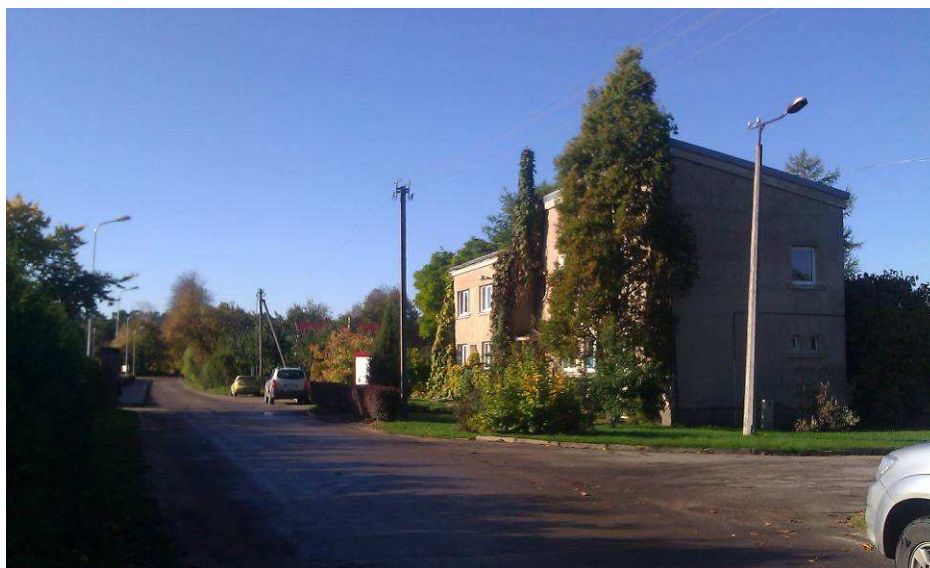
3.4.1. attēls. Krimūnas. Ceriņu ciema esošais nolietotais apgaismojums. Teritorija, kurā ieteicams uzstādīt apgaismojumu satiksmes un publiskās telpas drošības apsvērumu dēļ.
