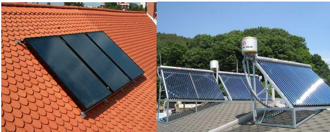
Attēls 5.4.1 Plakanie un vakuumcauruļu saules kolektori
