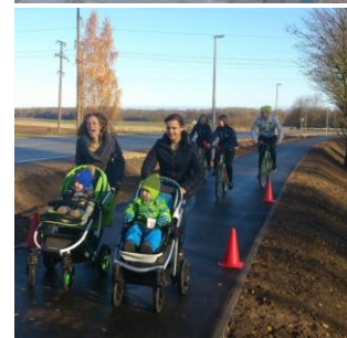
Gājēju un velosipēdistu ceļa izbūve Dobeles novada Virkus kapu sasiedzamībai (2017.)
