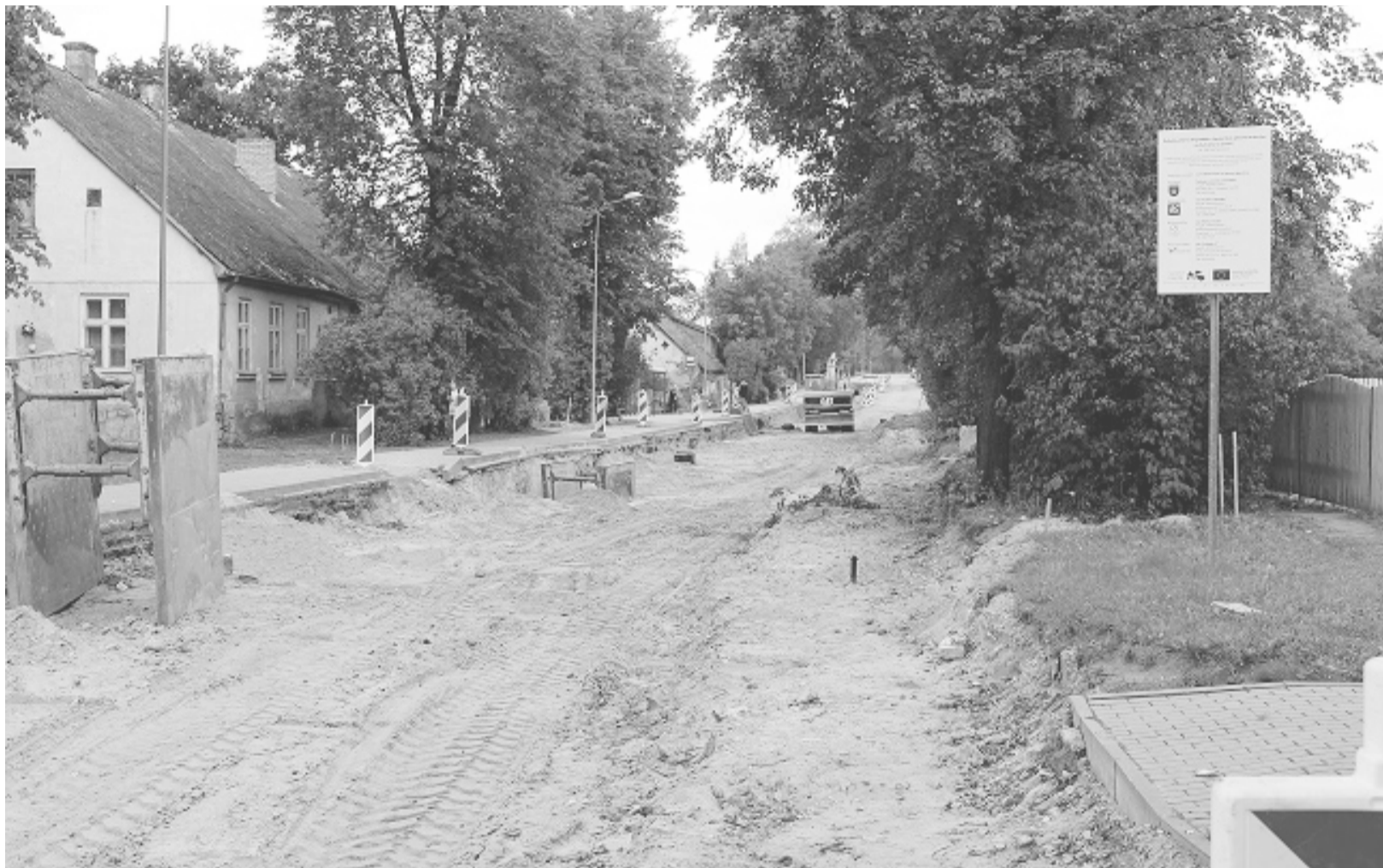
Uzvaras iela pārbūves laikā.
