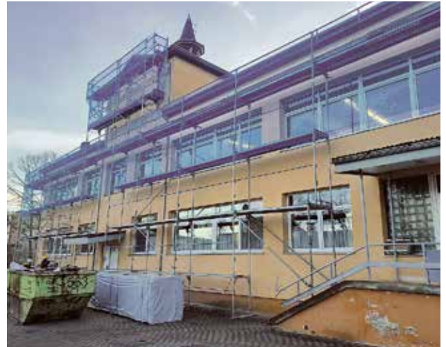
PII "Jāņtārpiņš" objekta aprīkošana ar sastatnēm.
