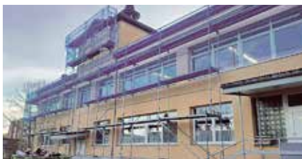
PII "Jāņtārpiņš" jumta seguma rekonstrukcijas 1. kārtā.
