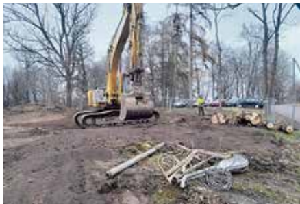
Ēkas Brīvības ielā 1, Dobelē, demontāžas un būvdarbu process.
