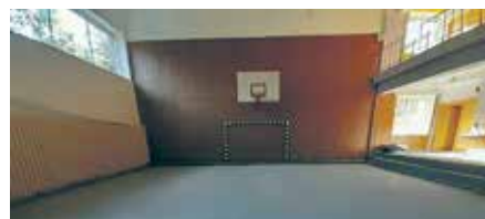
Grīda betona cietēšanas laikā.
